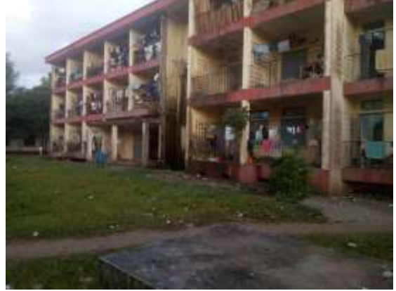
Figure 8: bloc de Logements d'universitaires Fianarantsoa
