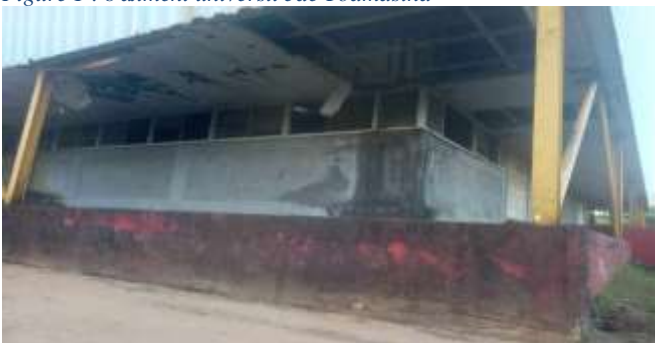
Figure 1 : bâtiment université de Toamasina
