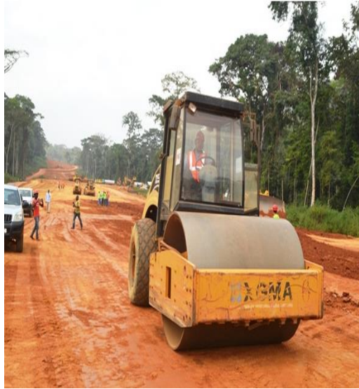
Photo 3.2 : Phase 2 de l'autoroute Yaoundé-Douala
