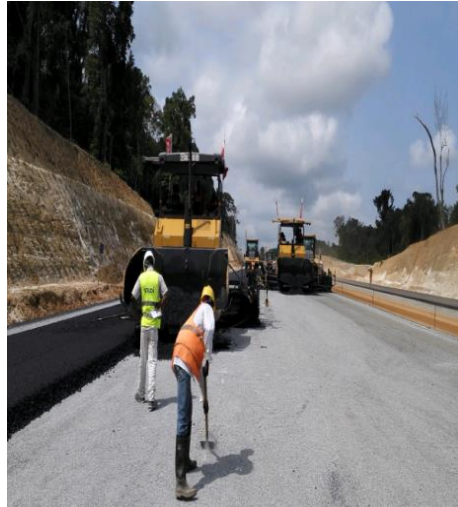
Photo 3.3 : Évolution des travaux de bitumage de l'autoroute Kribi-Lolabé Source : Cliché Roméo Aimé Kouanou, Kribi (zone rural) le 10 avril 2019
