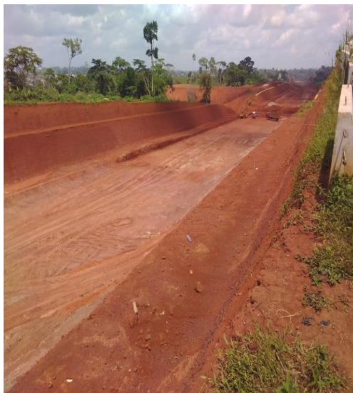
Photo 3.4: Travaux de construction de l'autoroute Yaoundé-Nsimalen lieu-dit Toutouli Source : Cliché: Roméo Aimé Kouanou, Toutoulli entrée Sud de Yaoundé, le 20 Avril 2017
